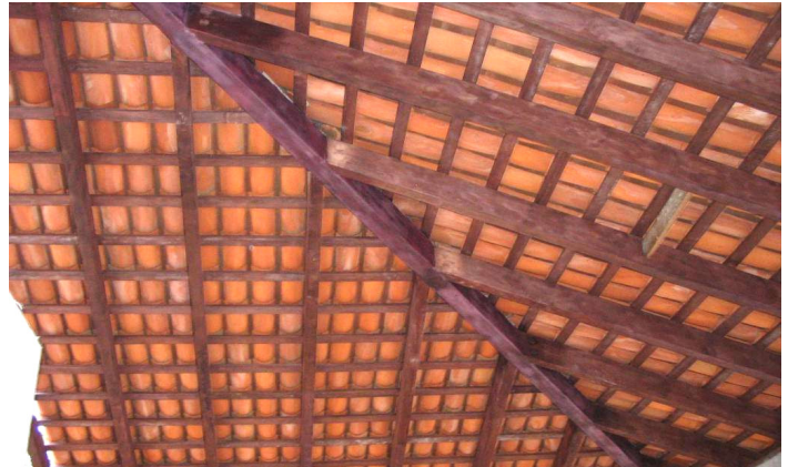
ENCHAPE DE VIGA METALICA EN TERRAZA CON DUROCK PARA SIMULAR MADERA (4/OCT/06)
